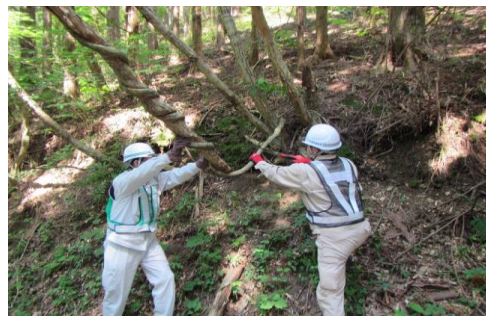
支障木撤去作業
