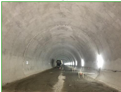
コンクリート覆工施工
