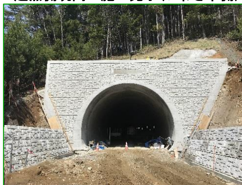
起点側坑門工施工完了(いわき市側)
