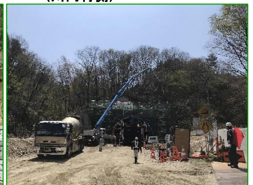
終点側坑門工コンクリート打設(川内村側)
