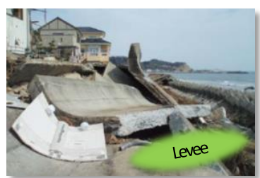
Iwaki City Levee
