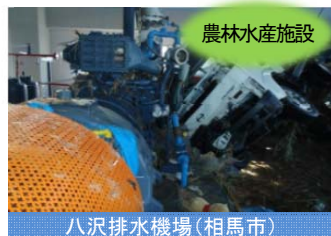
八沢排水機場 (相馬市)
