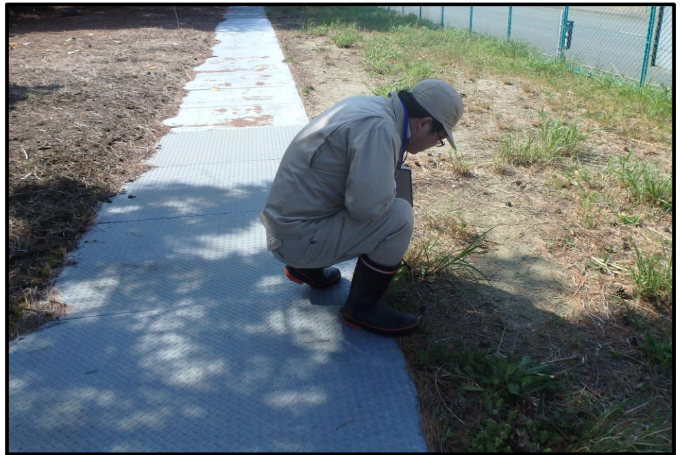
目視点検状況(4月19日撮影)
