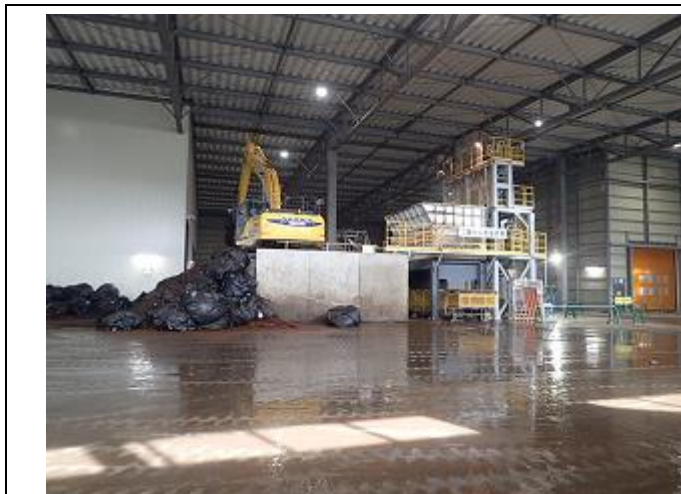
大熊町仮設焼却施設内部の状況確認
