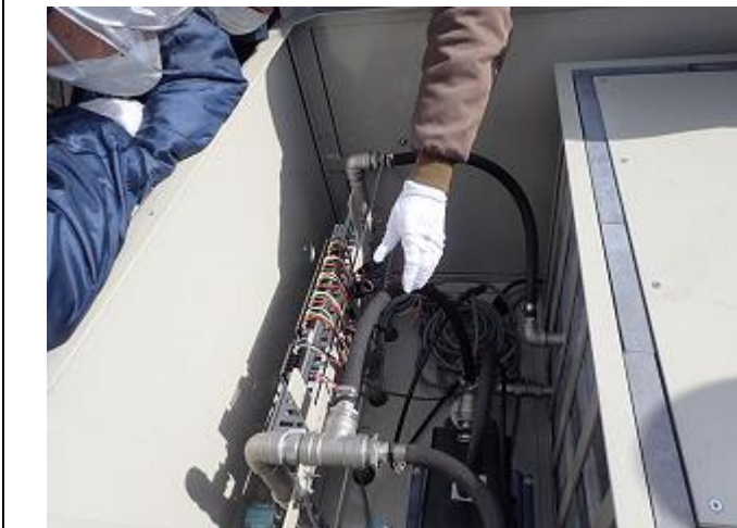
浸出水処理施設の水モニターの状況確認
