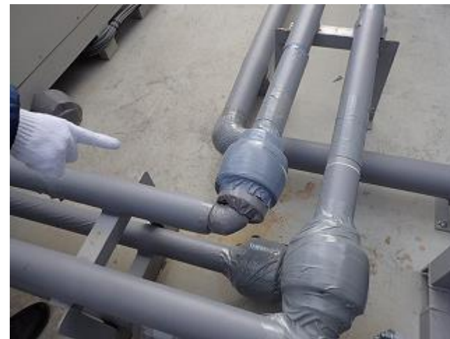
浸出水処理施設の配管部分の状況確認
