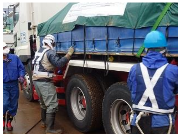
除去土壌等の積み込み作業確認
