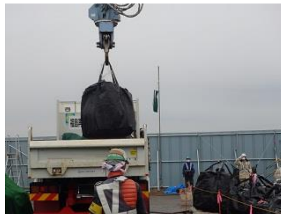
除去土壌等の積み込み作業確認
