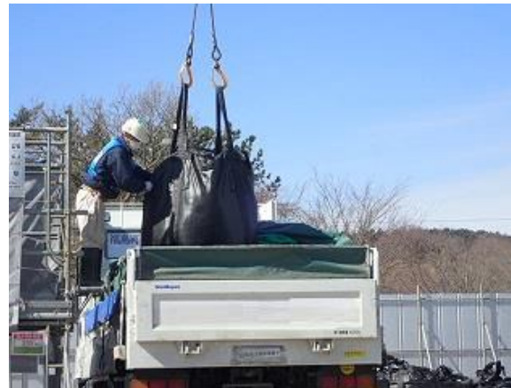
除去土壌等の積み込み作業確認
