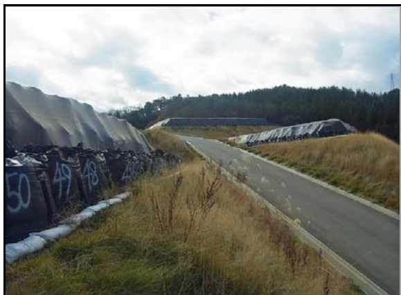
和田地区仮置場
