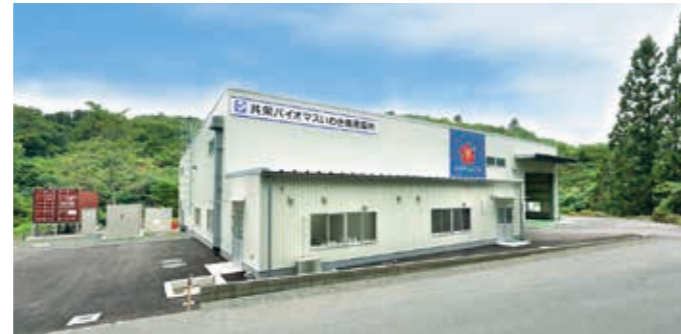
プラント全景写真
