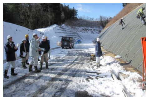
(アンカードリル施工中の状況)
