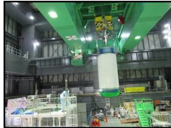
構内用輸送容器を使用済燃料プールへ移動 (撮影日2013年11月18日)
