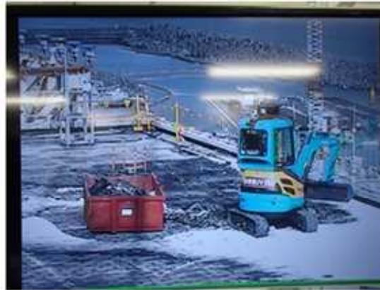
②遠隔重機による屋根保護層撤去状況
