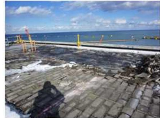
③遠隔重機による屋根保護層撤去完了状況
