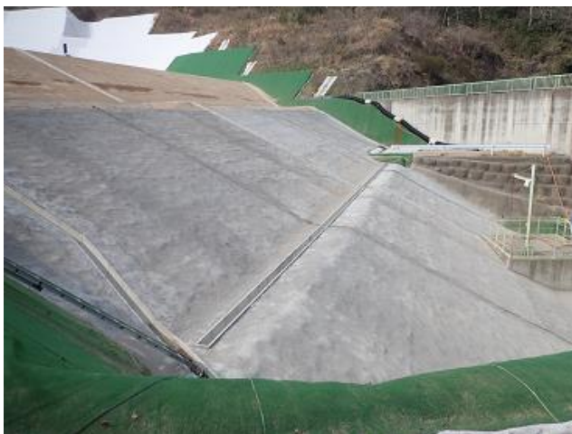
土堰堤の施工状況の確認
