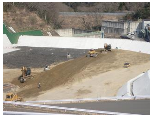
下流側埋立地の埋立直しの状況の確認
