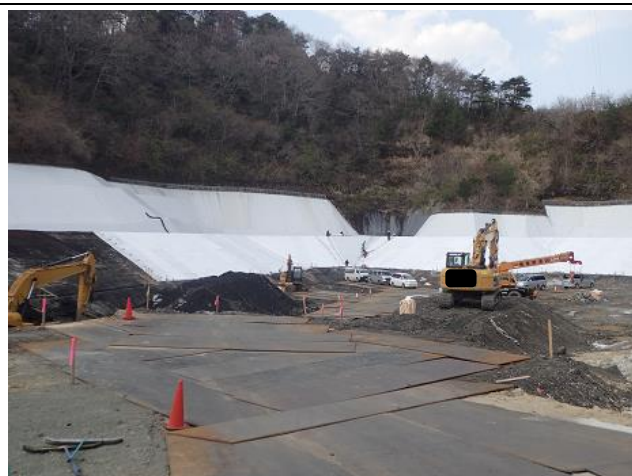
上流側埋立地の埋立直しの状況の確認
