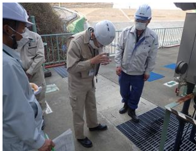
浸出水処理施設稼働状況の確認
