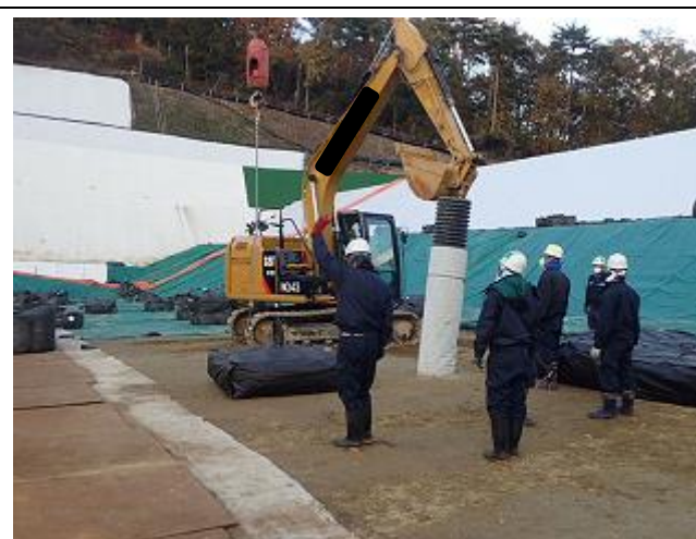
下流側埋立地への廃棄物搬入の確認
