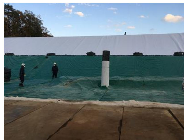
下流側埋立地作業終了時の確認
