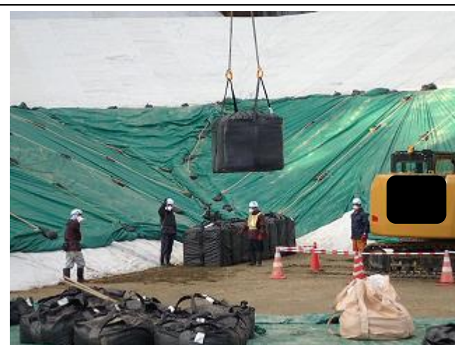
上流側埋立地への廃棄物搬入の確認
