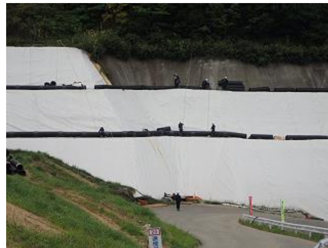
場内雨水配管の設置状況の確認
