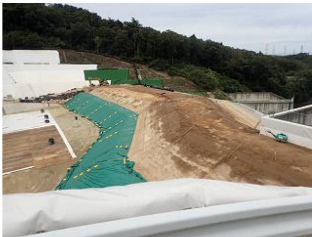
土堰堤の施工状況の確認
