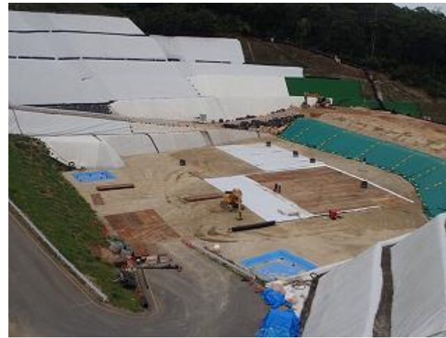
下流側埋立地のシート等設置状況の確認
