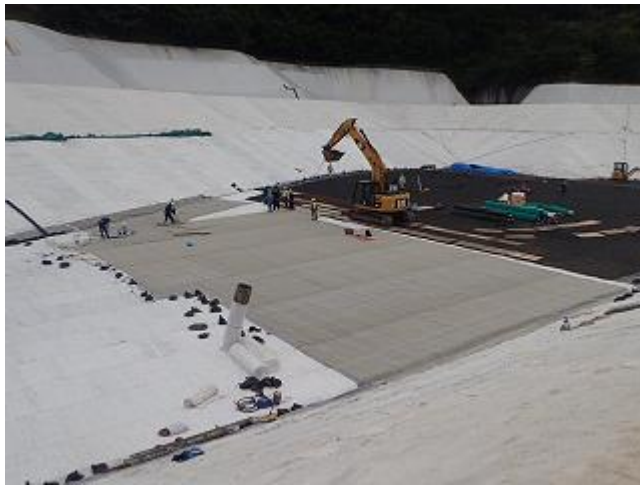
上流側埋立地のシート等設置状況の確認
