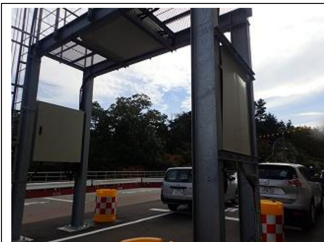
ゲートモニターの設置状況の確認
