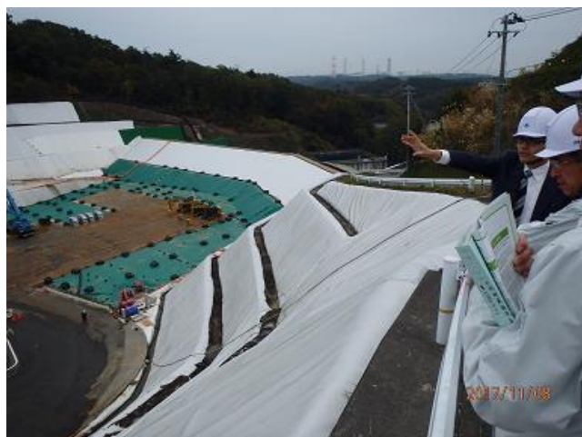
埋立地内の状況の確認
