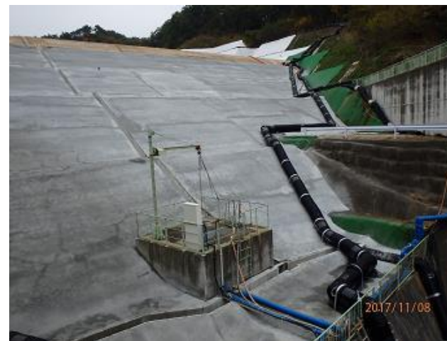
土堰堤の状況の確認
