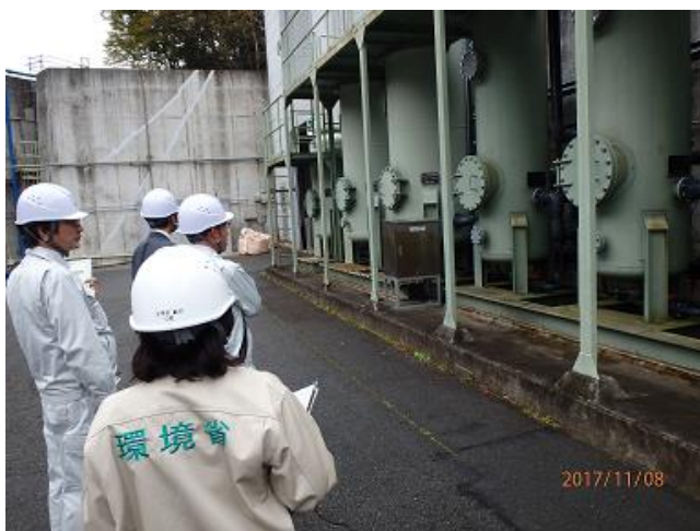
浸出水処理施設の確認
