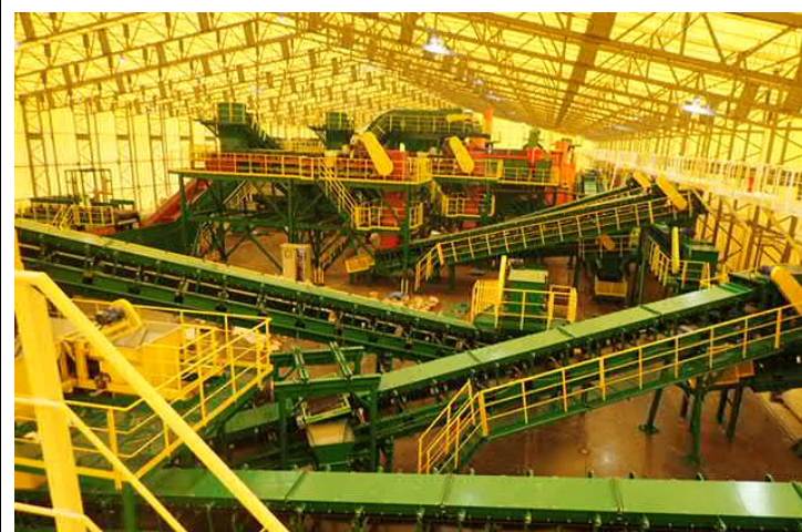
双葉工区受入・分別処理施設の確認
