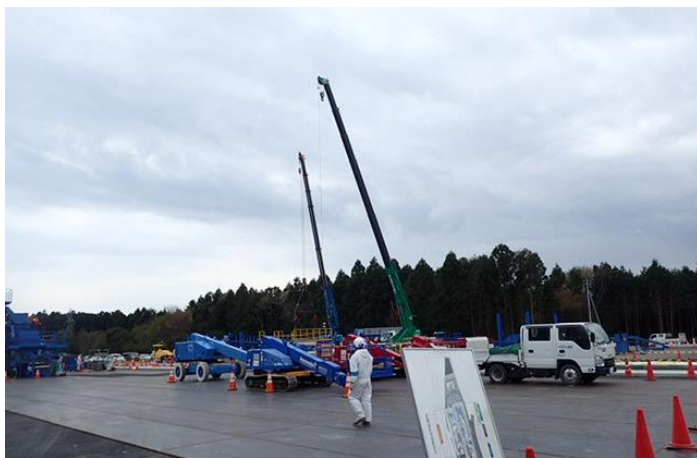
大熊工区受入・分別処理施設設置場所の確認
