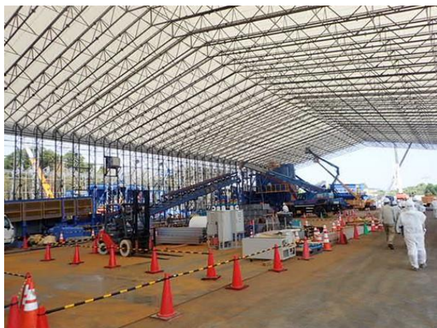
大熊工区受入・分別処理施設の確認
