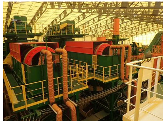
双葉工区受入・分別処理施設の確認
