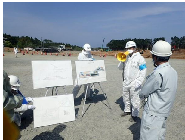
大熊工区土壌貯蔵施設設置場所の確認
