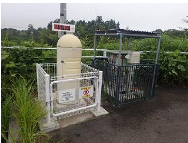
敷地境界における大気浮遊じん測定場所の確認
