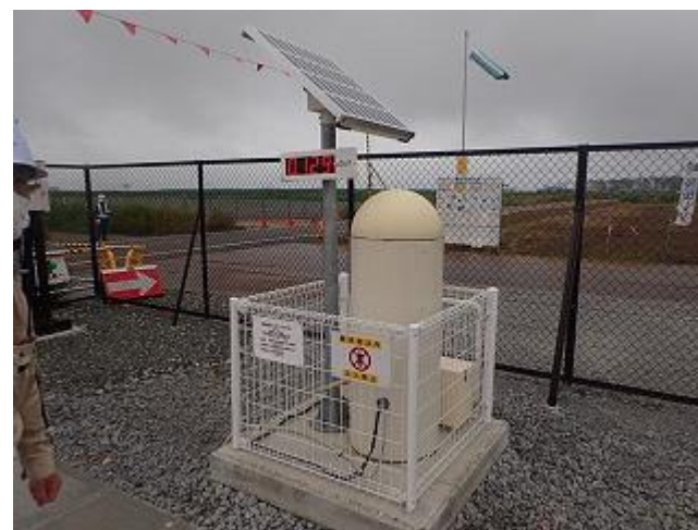
双葉工区受入・分別施設モニタリングポストの確認
