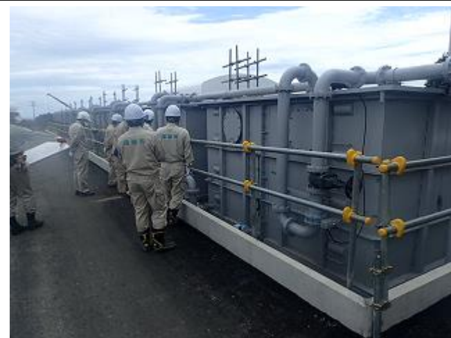
土壌貯蔵施設の設置状況の確認
