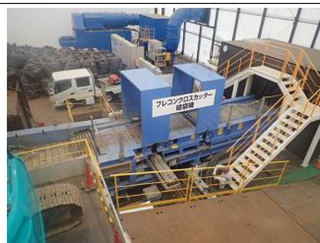
受入・分別施設の稼働状況の確認
