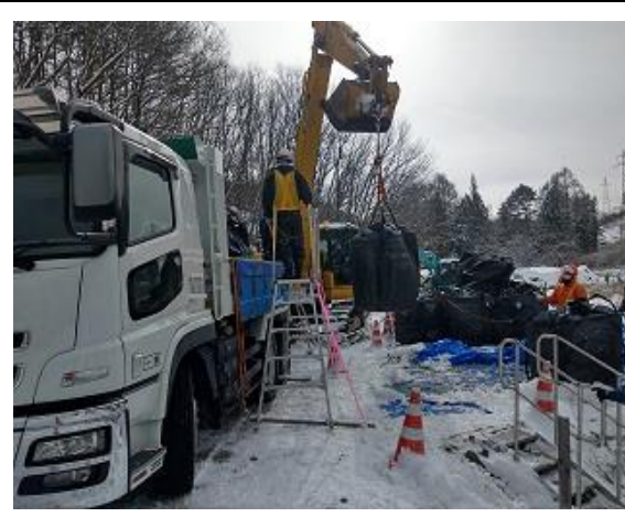
除去土壌等の積み込み作業確認
