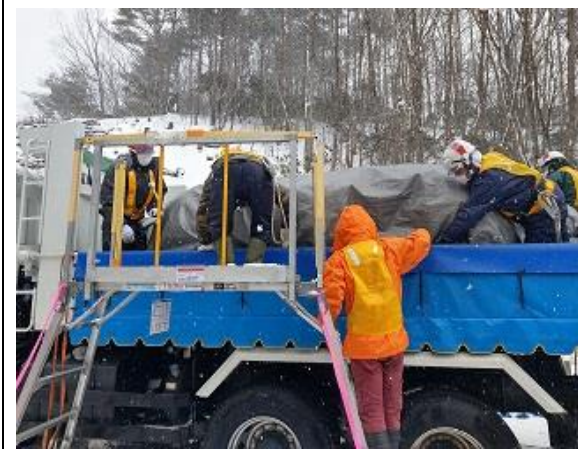
除去土壌等の積み込み作業確認
