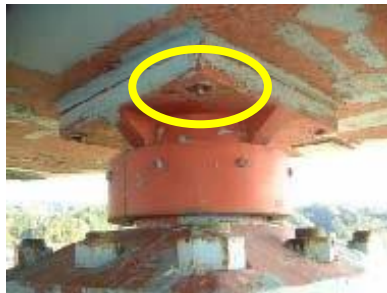
支承取り付けボルト等の破断
