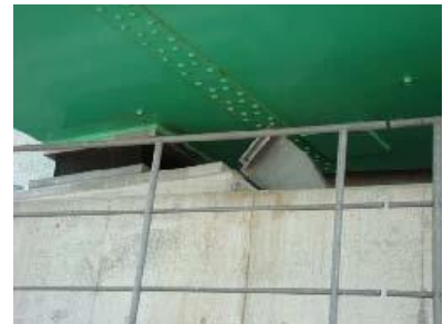
ジョイントプロテクター破損
