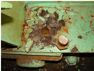
支承取り付けボルト等の破断
