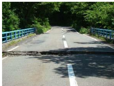
写真 7.6 橋台背面の沈下事例
