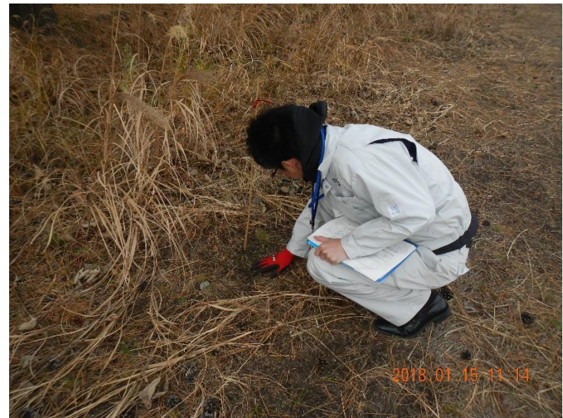
目視点検状況(1月15日撮影)
