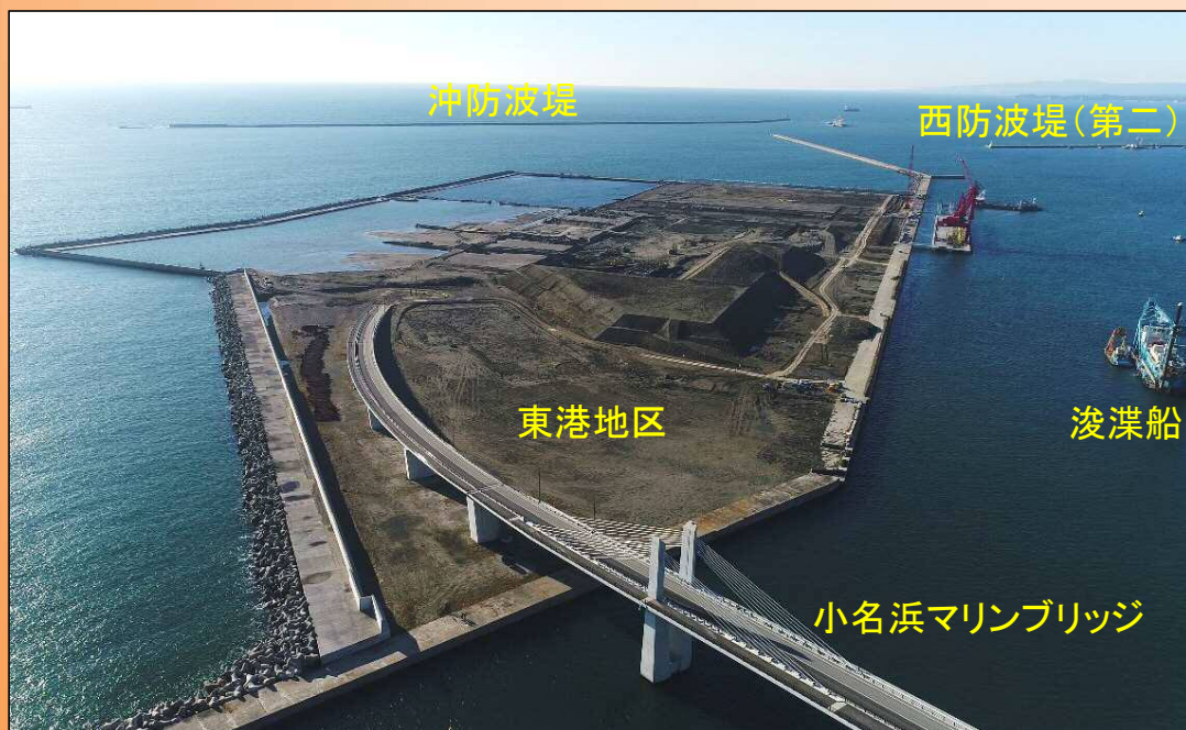
東港地区の空撮
