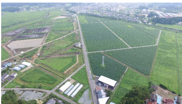
県営ほ場整備工事が進む「飯崎地区」
