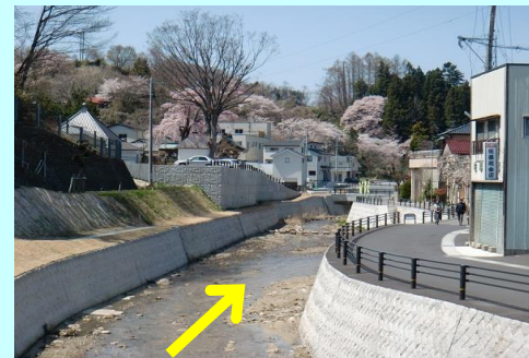
桜川（三春町）河川整備
