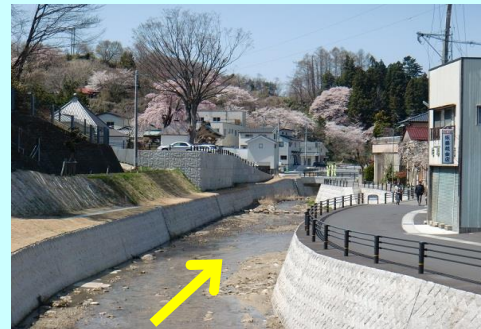
桜川（三春町）河川整備
