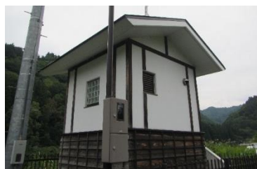
福島県河川流域総合情報システム 浜野雨量水位観測局舎 (伊南川/福島県南会津町)
