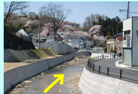
桜川（三春町）河川整備
