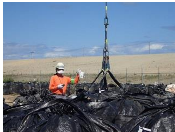
除去土壌等の積み込み作業確認 1
