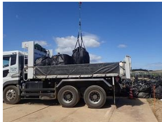
除去土壌等の積み込み作業確認 2
