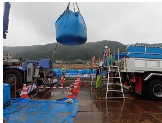
除去土壌等の積み込み作業確認
