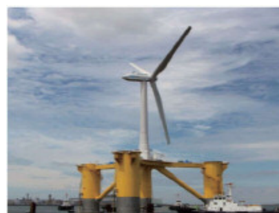
2メガワットダウンウインド 浮体式洋上風力発電設備
