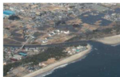
錦・関田地区ほ場整備予定地
