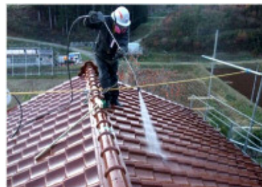
住宅の除染作業
