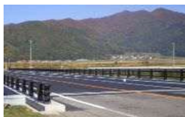
橋梁の長寿命化対策(施工後)
