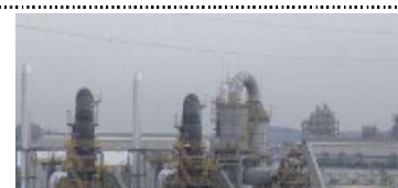
仮設焼却炉の設置
