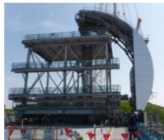
ドーム屋根組立訓練
