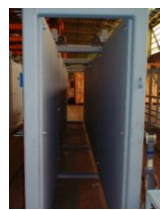
②25mmの鉄板と33mmの鉛毛マットによる遮へい体の設置（鉛毛マット取付前）
