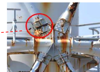
△ 破断箇所の様子▽
