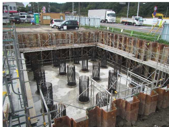
橋脚部：基礎杭の施工が完了！
