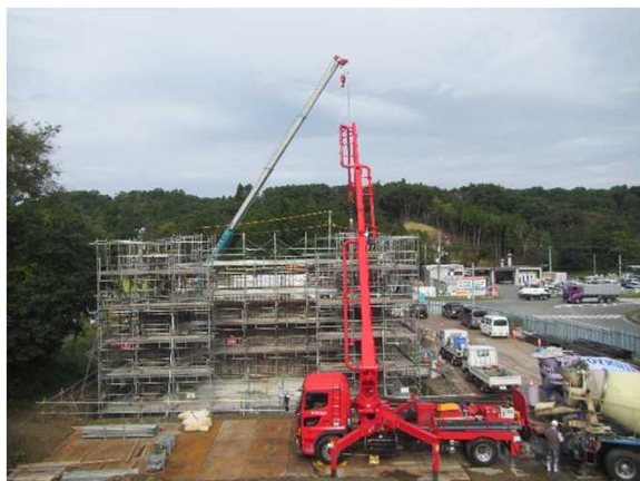
橋台部：コンクリートポンプ車で打設状況
