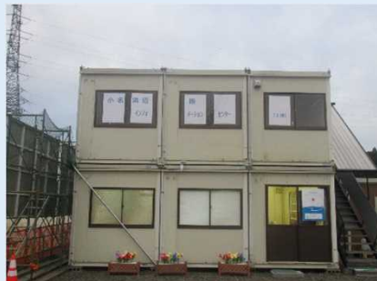
インフォメーションセンターは 建物の1階です。
