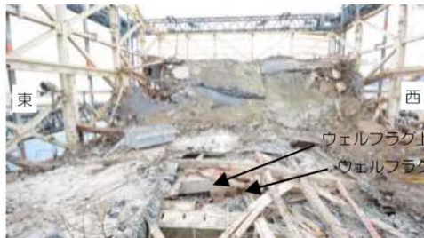
<オペフロの様子（崩落屋根等）>
