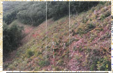
施工前 (No. 401付近)
