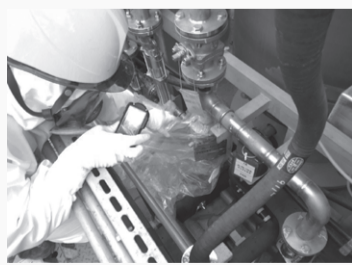
現地駐在員による状況確認
