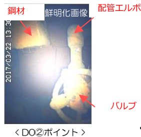
<1-9. 鋼材、配管エルボ、バルブの鮮明化画像 >
