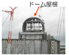
<1-24. ドーム屋根設置状況>
