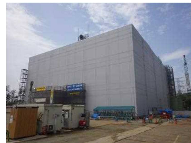
雑固体廃棄物焼却設備（建屋全景）
