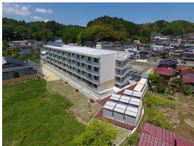
復興公営住宅 《若宮団地（二本松市）》 RC(PC)造4階建て32戸(5/17竣工)
