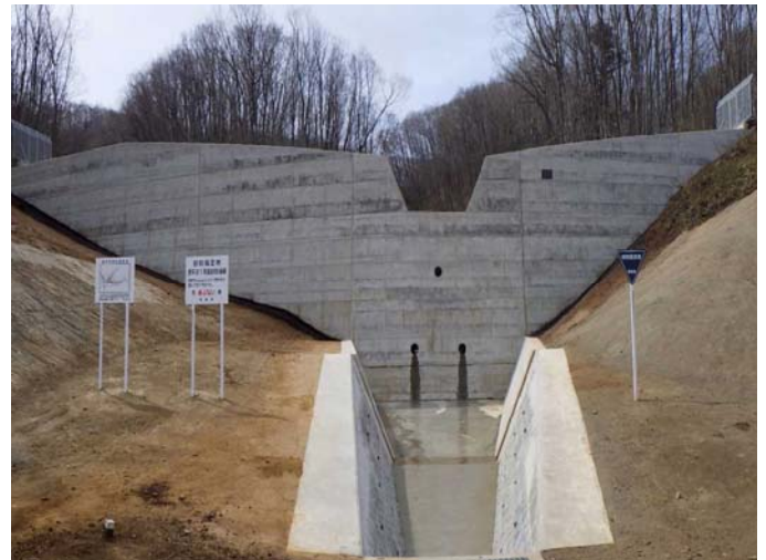
砂防えん堤（彦平沢1号） [伊達市霊山町] 平成28年度竣工
