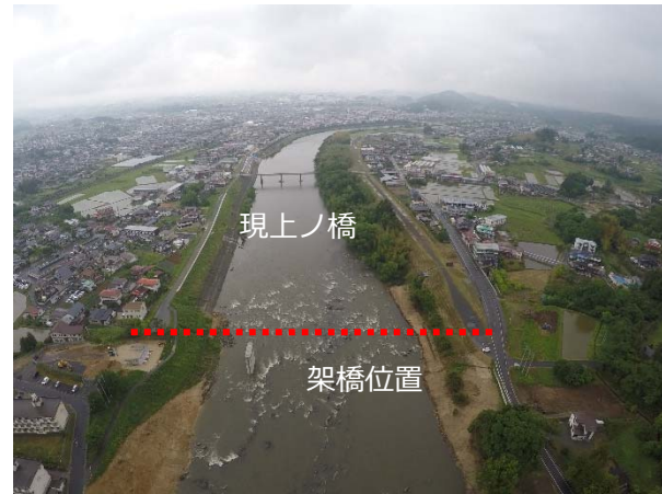
二本松金屋線 上ノ橋（本宮市仁井田）
