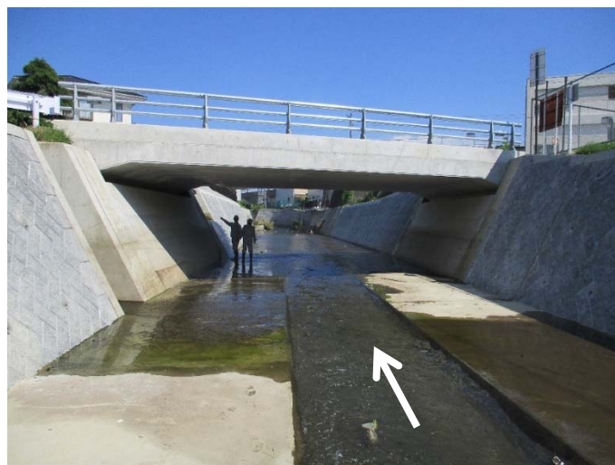
蛭川（福島市瀬上町）開削護岸
