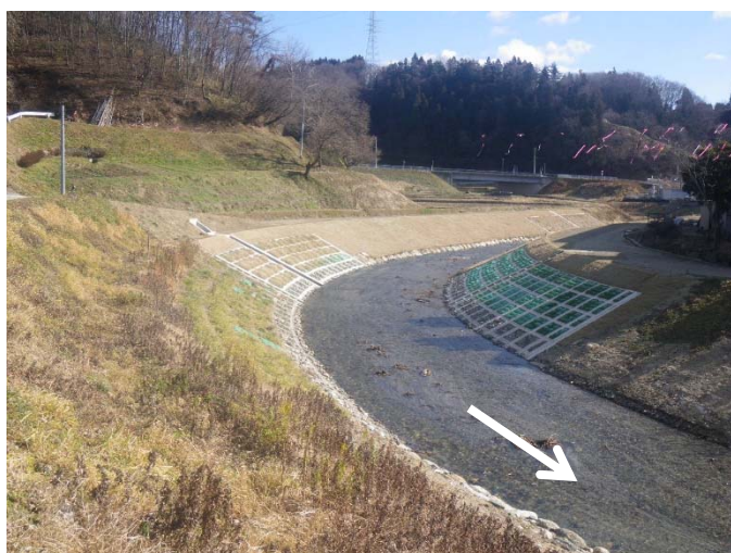
安達太田川（二本松市太田）開削護岸
