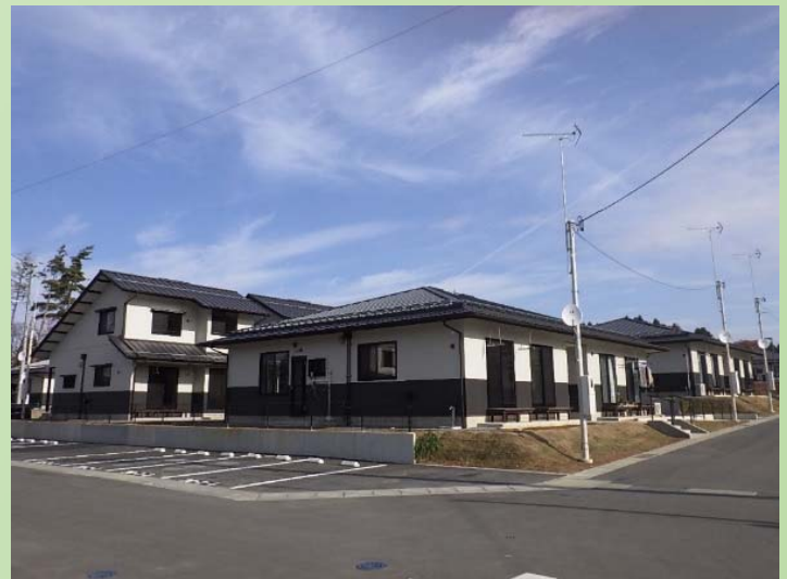
【復興公営住宅整備】 根柄山団地 H28.9入居開始
