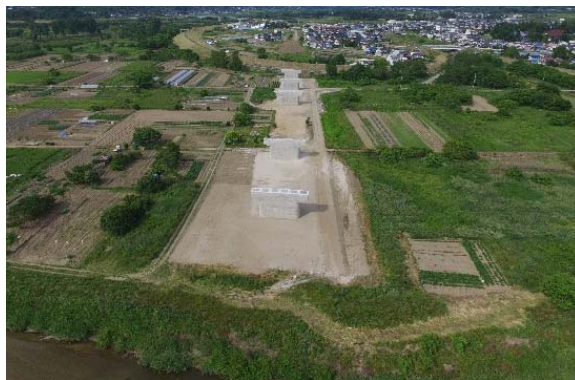
国道349号 梁川バイパス（伊達市梁川町）
