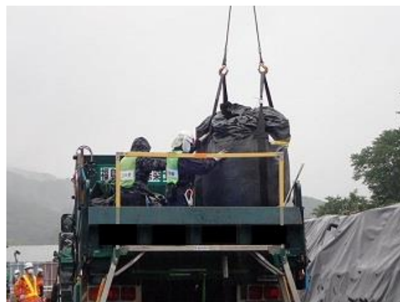
除去土壌等の積み込み作業確認 2
