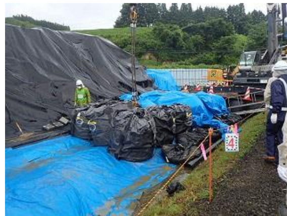
除去土壌等の積み込み作業確認 1
