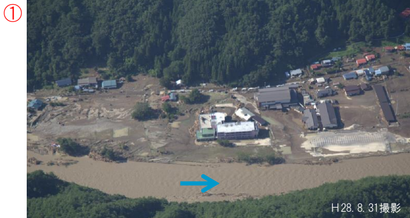
被災状況写真
