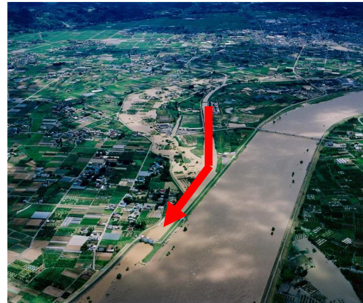
一級河川東根川 伊達市・阿武隈川合流付近 平成14年8月台風
