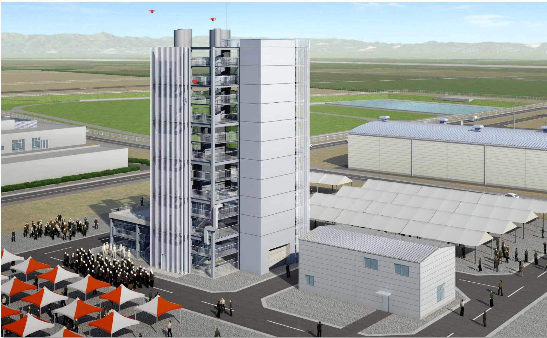
試験用プラント：10m×12m×H30m（6階建、1階のみ20m×12m）
