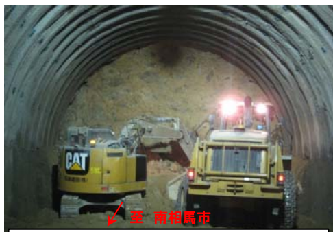
①八木沢工区のトンネル整備状況
