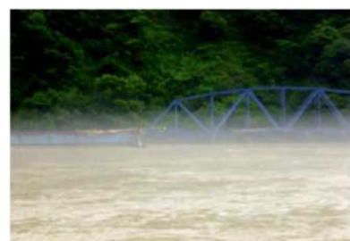
水位の状況(只見町提供)
